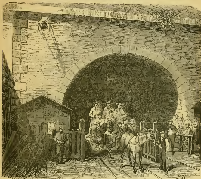
FIG. 55 — OUVERTURE DU TUNNEL
